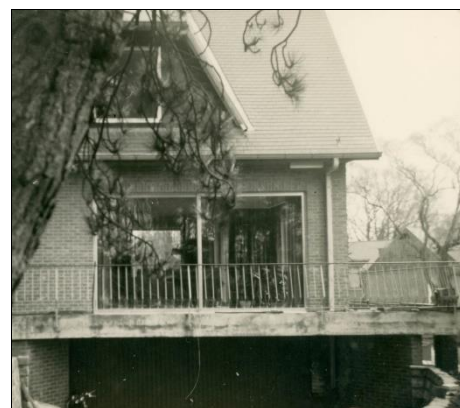
De woning met de betreffende balustrade waar het ongeluk mee gebeurde.
